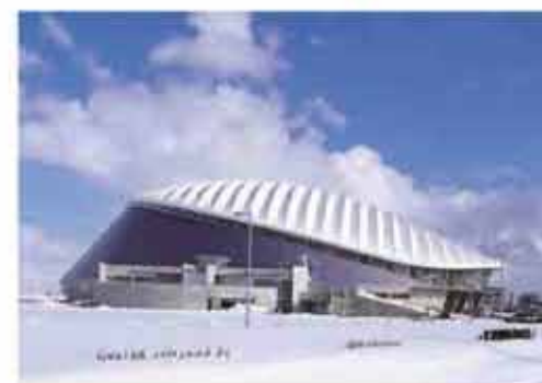
[Sapporo Community Dome] Владелец: город Саппоро Архитектор: Mitsubishi Estate/ Atelier BWK/ Taisei Corporation/ Iwata Construction JV Инженер: Mitsubishi Estate/ Atelier BWK/ Taisei Corporation/ Iwata Construction JV Строитель: Taisei Corporation/ Iwata Construction JV Мембрана Type: PTFE + Glass Fiber Teflon Площадь мембранной конструкции: 11062 м 2
