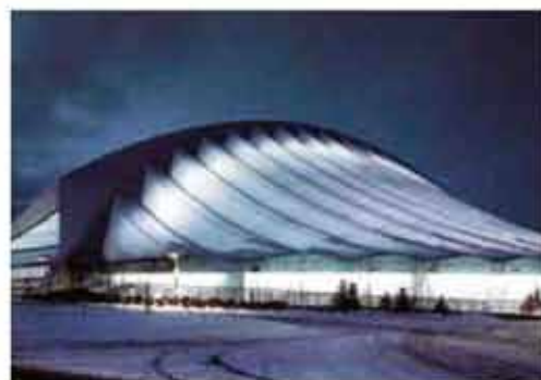
[Talisman Centre] Тип мембраны: ПТФЭ с покрытием TiO 2 (внешний слой), Fabrasorb (внутренний слой) Площадь мембранной конструкции: 13,800 м 2 материал Teosothene с покрытием TiO 2
