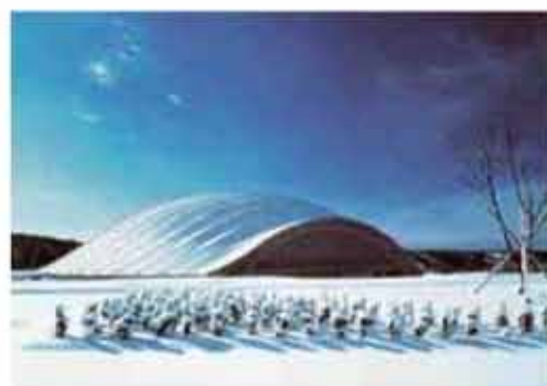
[Akita Sky Dome] Владелец: Kajima Corporation Строитель: Kajima Corporation Тип мембраны: ПТФЭ + стеклоткань с тефлоновым покрытием Площадь мембранной конструкции: 11500 м 2
