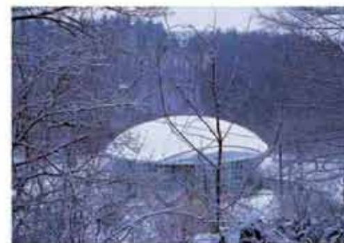
[Tsunagi Elementary School] Владелец: Департамент образования Yamagata Архитектор: Zero Architect Инженер: Zero Architect Строитель: Gamparo Construction Тип мембраны: ПТФЭ + стеклоткань / Поликарбонат + PES (внутренний слой) Площадь мембранной конструкции: 795 м 2
