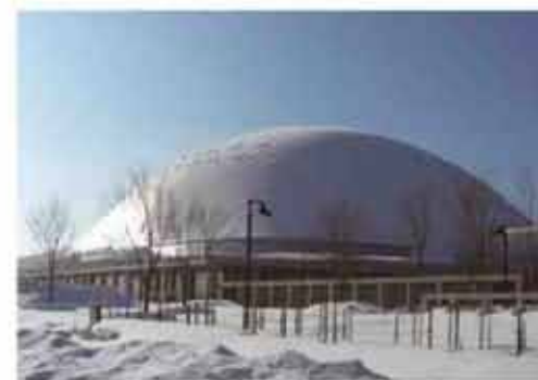
[Shimokita Dome] Владелец: Префектура Аомори Архитектор: Hiroshi Hara + Atelier Fal Architect/ Taisei Corporation Строитель: Taisei Corporation Тип мембраны: ПТФЭ + стеклоткань (SF-A) + Fabrasorb Площадь мембранной конструкции: 9,700 м 2
