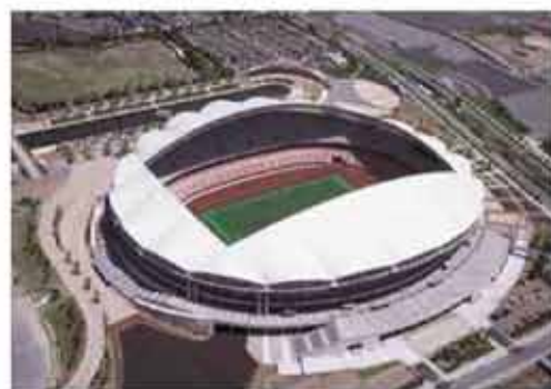
[Стадион «Big Swan» в г. Ниигата] Архитектурно-техническое решение: Nikken Sekkei Ltd. Строительство: 1-й участок: Kajima, Fukuda, Kagata JV, 2-й участок: Shimizu, Hoshima, Maruani JV, 3-й участок: Taisei, Daiichi Kensei, Lotte Construction JV, Площадь застройки: 36,703 м 2 Площадь мембранной конструкции: 23,500 м 2
